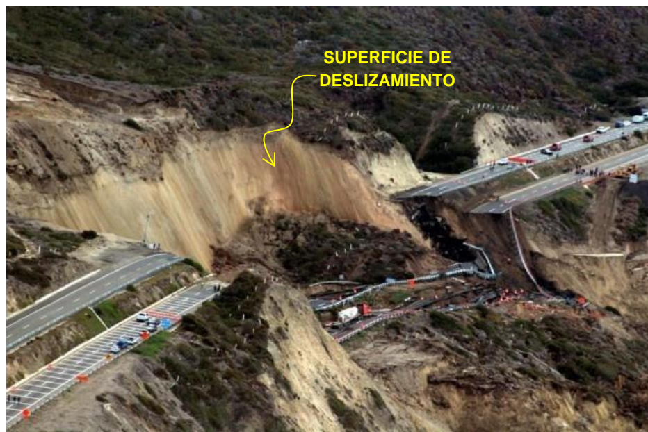
FIGURA 23.- FALLA EN LA CARRETERA TIJUANA - ENSENADA. PUBLICACIÓN DEL 29 DE DICIEMBRE DEL 2015 FUENTE: PERIÓDICO 4 VIENTOS.
